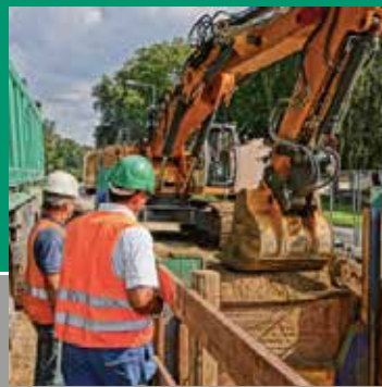
Tief-, Kanal- und Wasserbau
